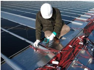
*Messung des DC-Stroms von Solarpanel-Strängen*
