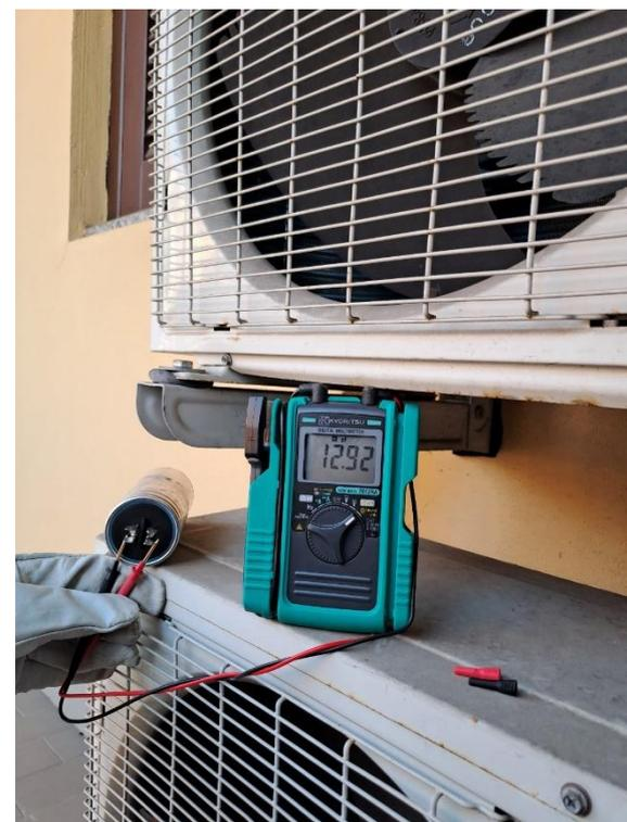
*Bei der Wartung einer Klimaanlage können Kondensatoren oder Dioden gemessen werden*
