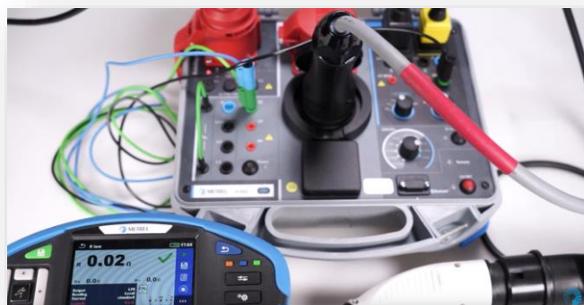
EVSE Mode 3 Kabel Test
