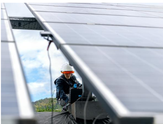
MI-3116 PV Analyser im Einsatz
