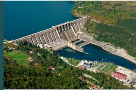
Monitoring der strukturellen Stabilität eines Dammes in Serbien
