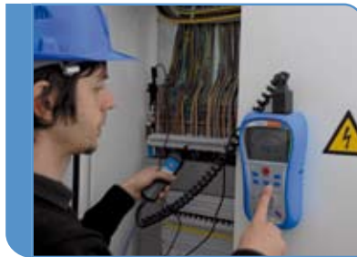
Isolationsmessung an Schaltschränken.
