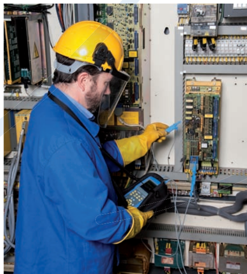
Funktionsprüfung an der elektronischen Steuerung einer Werkzeugmaschine
